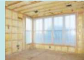
天井・壁・床等の断熱改修
